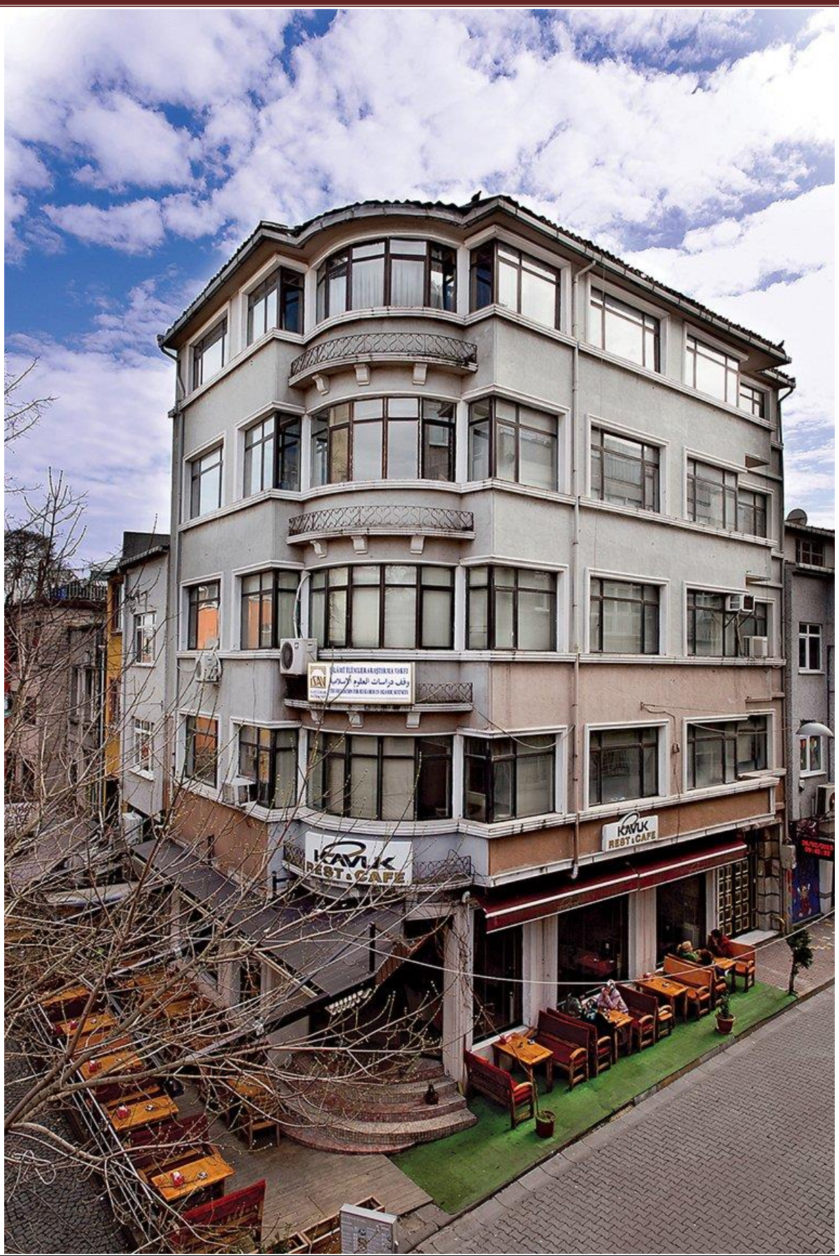
Vakıf merkezi binamızın dıştan görünümü
